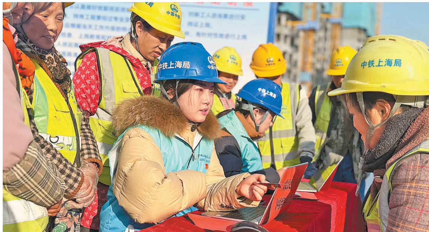
1月11日,在中铁上海工程局三公司安徽合肥榆林桥畔安置房项目部,志愿者帮助即将踏上返乡之路的农民工订购过年回家的车票。李博摄(影像中国)
