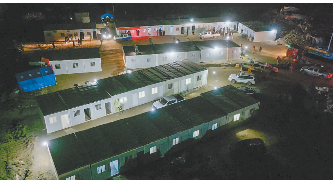
抗震保温、防晒防潮,设有住宿洗漱、就医学习等功能区……1月10日,西藏定日县地震灾情严重的长所乡多个安置点快速搭建活动板房。相比临时安置的救灾帐篷,活动板房更坚固耐用、安全温暖,标志着受灾群众生活转向过渡期安置。图为10日20时30分左右,长所乡古荣村活动板房全部通电。本报记者 张武军摄
