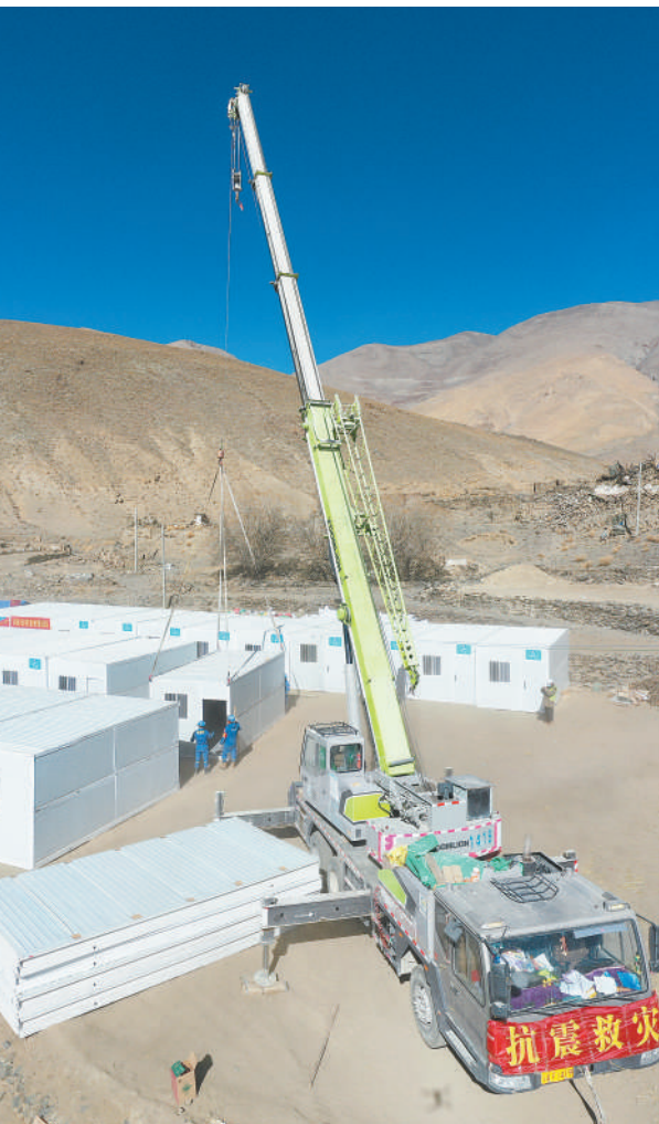
上图:1月9日,在定日县长所乡古荣村安置点,施工人员进行抓紧搭建移动板房。
