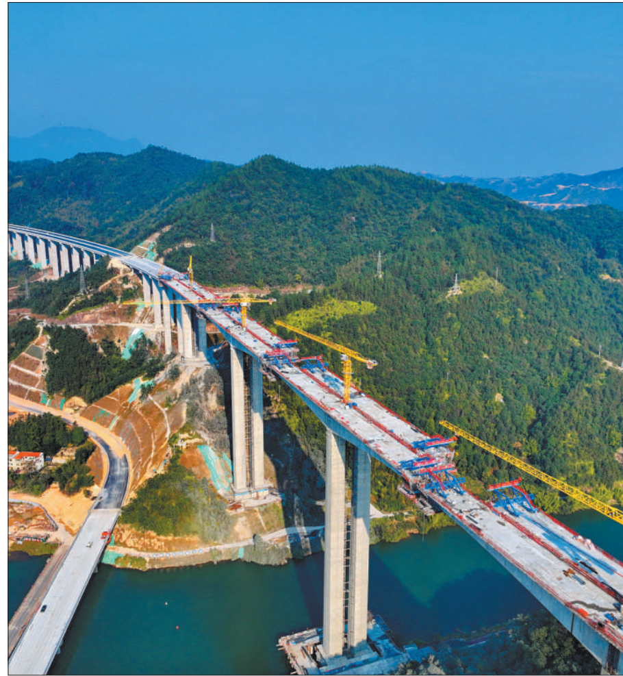
江西赣州的上犹江特大桥项目施工现场，工人正在进行桥面施工。朱海鹏摄(影像中国)
