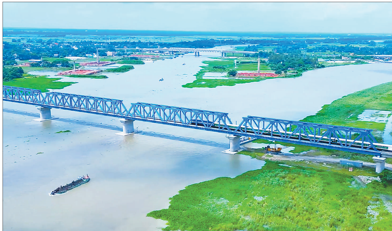
中国企业承建的孟加拉国最大铁路项目帕德玛大桥铁路连接线日前开通运营。帕德玛大桥铁路连接线由中国中铁股份有限公司承建，全长170公里，首通段已于2023年10月开通。孟加拉国铁道部相关负责人表示，该铁路连接线的运营将极大缩短首都达卡和西南部城市之间的通行时间，更开启了孟加拉国铁路发展史上的新篇章，该铁路连接线将有力促进沿线地区经济发展。因为在帕德玛大桥铁路连接线上，列车驶过一座大桥。中国中铁股份有限公司供图
