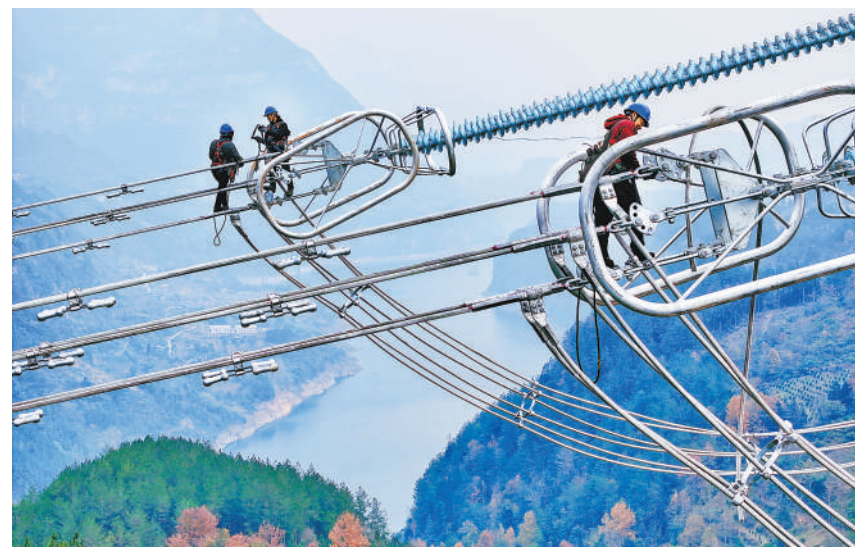
湖北恩施市红土乡乌鸢坝村,金上至湖北特高压项目施工现场,工人在紧线、安装附件。张远明摄(影像中国)
