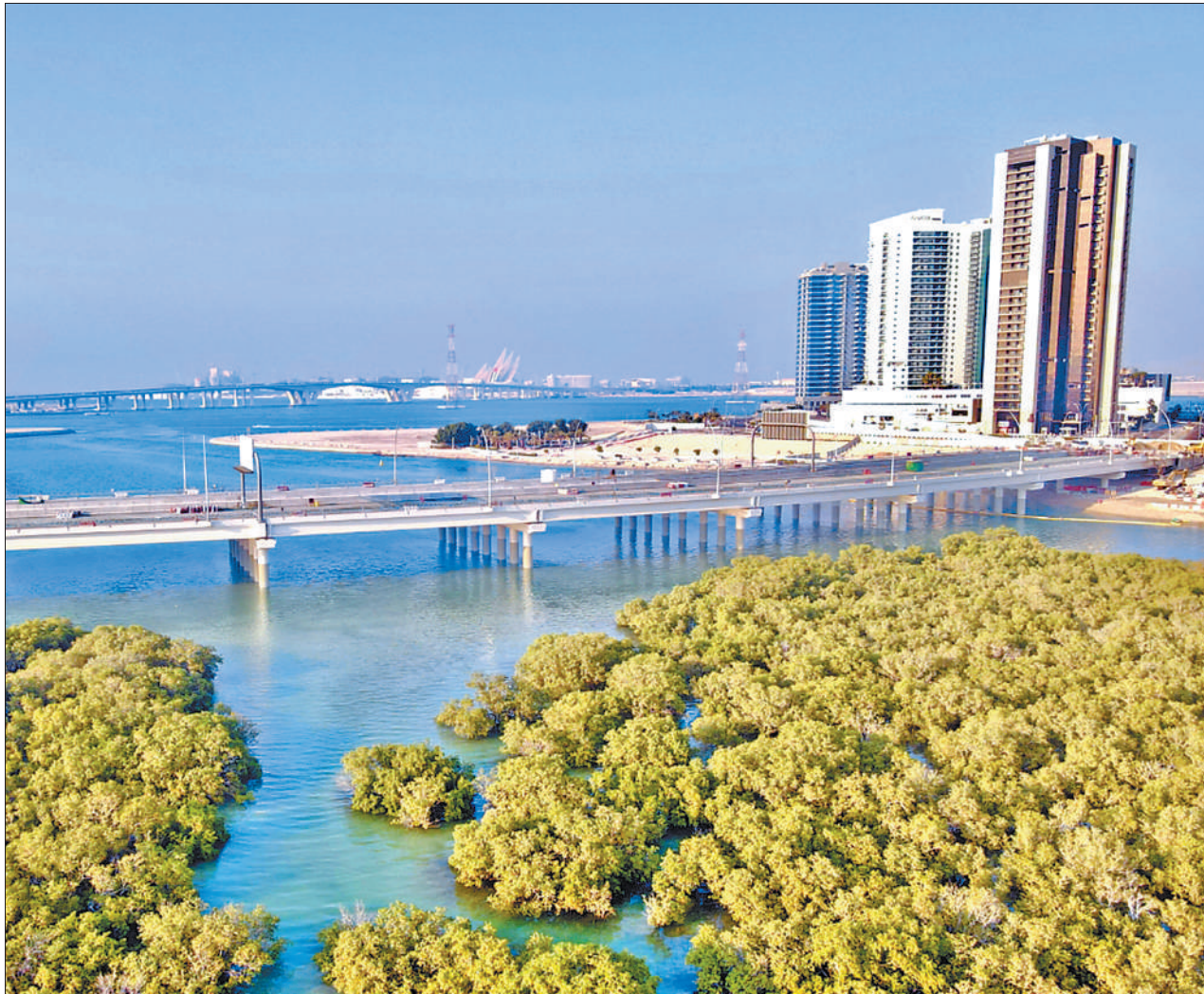
阿联酋阿布扎比瑞姆岛跨海桥项目施工现场。
