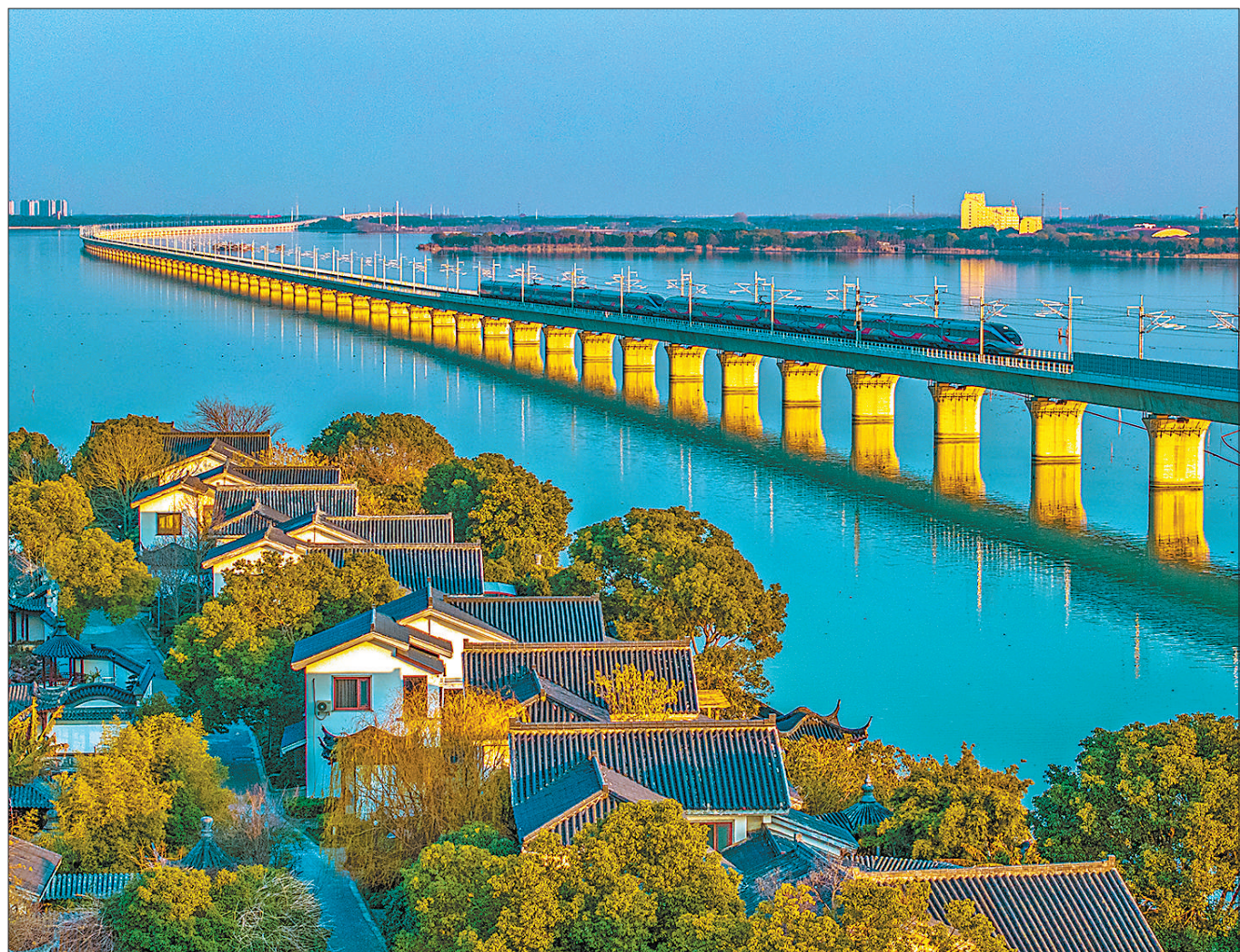
日前,沪苏湖高铁正式开通运营。沪苏湖高铁自上海虹桥站引出,途经江苏省苏州市,终至浙江省湖州市湖州站。图为1月2日,列车飞驰在沪苏湖高铁元荡湖大桥。
