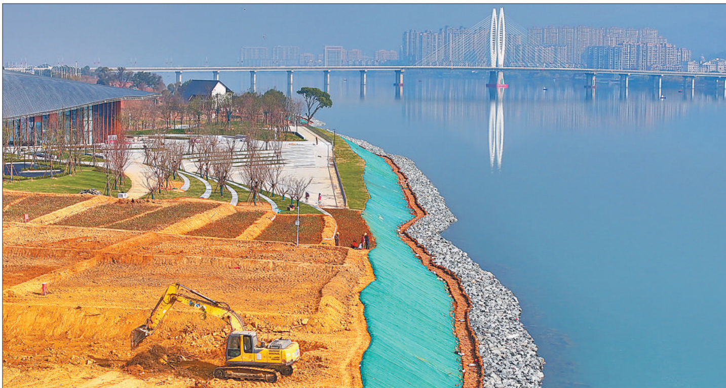
1月1日，江西省吉安市吉水县赣江江滩，挖掘机在进行表土剥离，为种植草皮、树木等做准备。吉水县对赣江沿江江滩裸露场地及岸线破坏处进行生态修复，建设江滩绿道，打造绿色休闲空间，为市民和游客提供更多运动休闲的好去处。 朱海鹏摄（影像中国）
