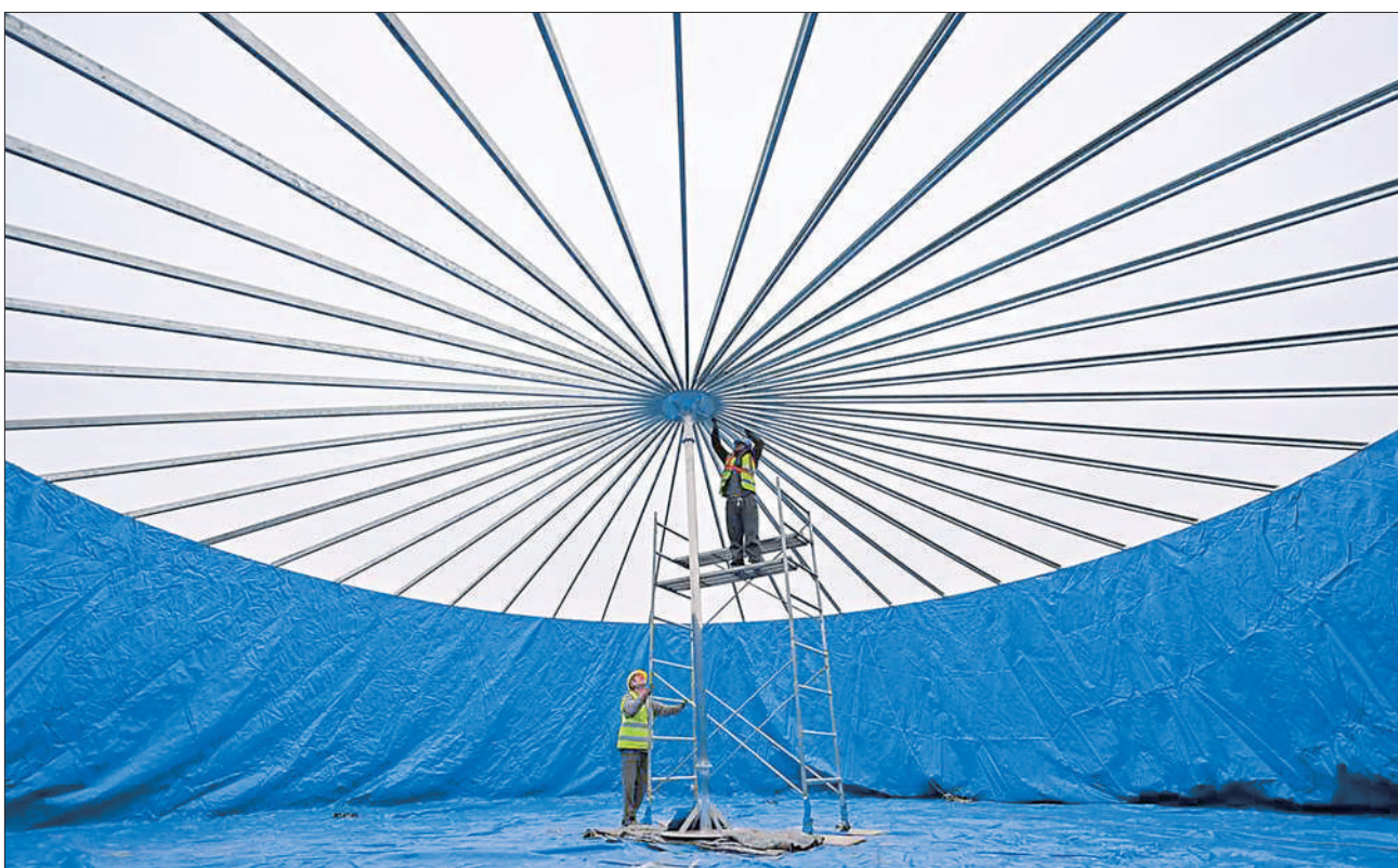
12月29日,四川省仁寿县富加镇明珠村,施工人员在安装装配式蓄水池。仁寿县地处丘陵地区,当地因地制宜,在推进高标准农田建设中,配套建设施工便捷、节能环保的装配式蓄水池,助力农业灌溉等。
