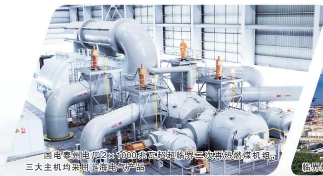
国电泰州电厂2×1000兆瓦超超临界二次再热燃煤机组，三大主机均采用上海电气产品
