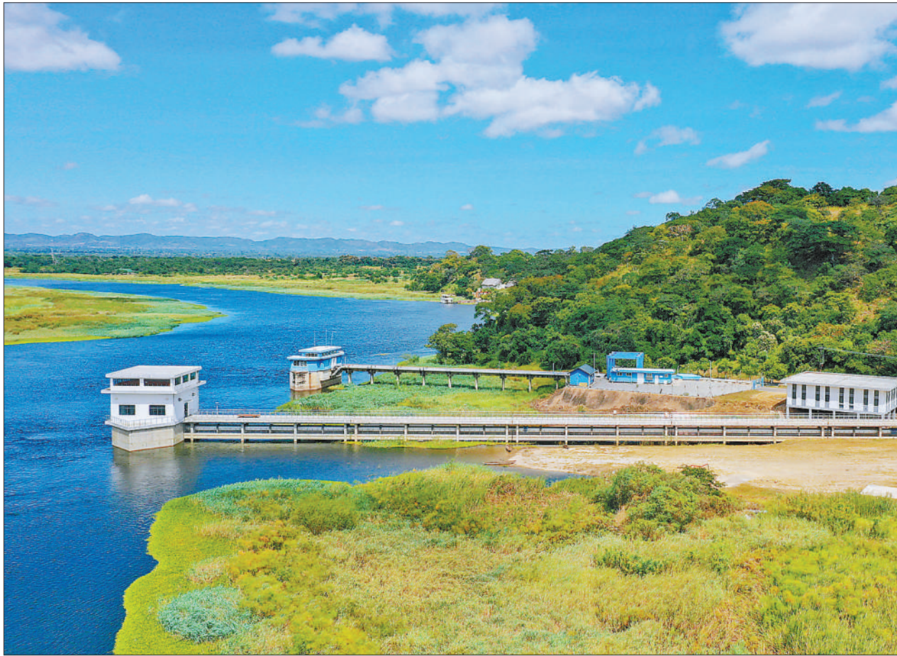
卡富埃河供水项目一期工程取水泵站。
