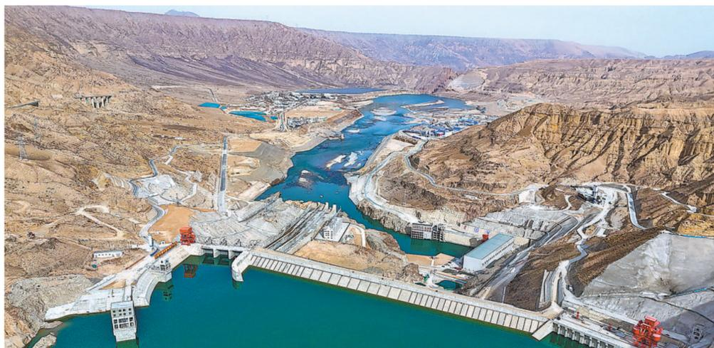
12月24日,位于黄河上游的青海羊曲水电站最后一台(3号)机组正式并网发电,标志着羊曲水电站按期实现全容量投产发电目标。该水电站在国内首创采用镶块混凝土面板堆石坝新坝型。图为羊曲水电站。本报记者 贾丰文 新华社记者 张龙摄
