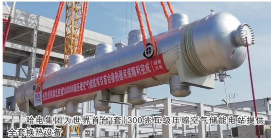
哈电集团为世界首台(套)300兆瓦级压缩空气储能电站提供全套换热设备
