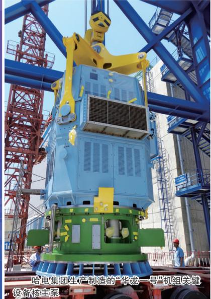
哈电集团生产制造的“华龙一号”机组关键设备核主泵
