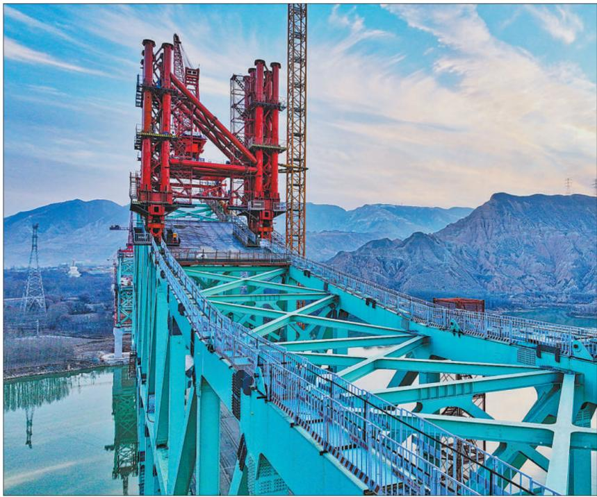
作为新建川青铁路(成都—西宁)重要控制性工程,由中铁大桥局建设的尖扎黄河特大桥正在加紧施工。位于青海黄南藏族自治州尖扎县和海东市化隆回族自治县交界处的尖扎黄河特大桥,是世界跨度最大的双线铁路连续钢桁拱桥,也是我国第一座跨越黄河的铁路钢桁拱桥。图为尖扎黄河特大桥施工现场。
