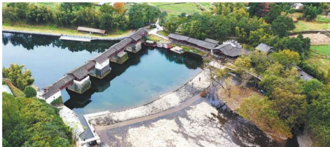
人工夯实,形成一个整体,能够有效地将水压力传递至河床和两岸基岩。工程规模因需而定,以低矮石碣为主,多级设置,既能合理蓄水,又降低了施工难度,确保了工程的坚固久安。
