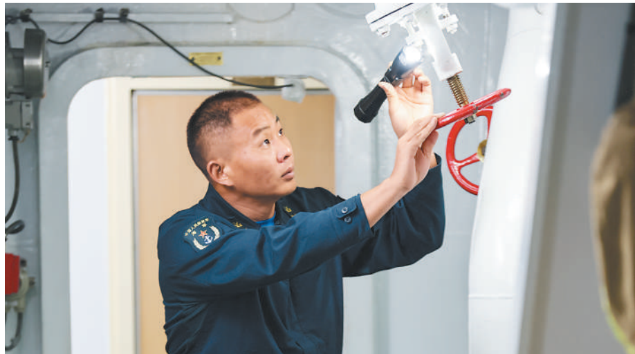
周帅正在检查管路运行情况。 杨云翔摄
