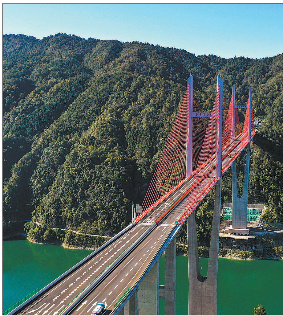
贵州剑黎高速南孟溪大桥,车辆在绿水青山间畅行。
