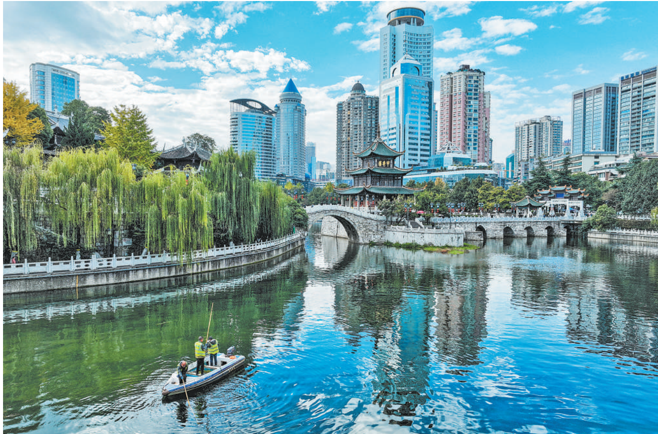
贵州贵阳市持续推进南明河水环境综合整治，目前，南明河水质全年稳定达到地表水Ⅳ类，生态系统完整性显著提升。图为11月29日，工作人员在南明河上进行清淤作业。
