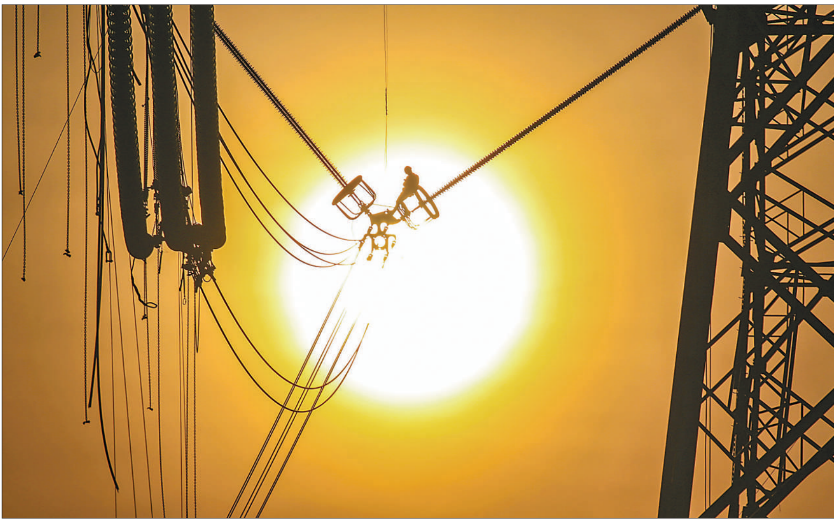
近日,湖南湘西土家族苗族自治州龙山县洛洛镇,工作人员争分夺秒,检修特高压直流输电线路。特高压项目是“新基建”的重要领域之一,具有投资规模大、产业链长、带动力强等特点。中長期经济效益显著。 曾祥辉摄(影像中国)
