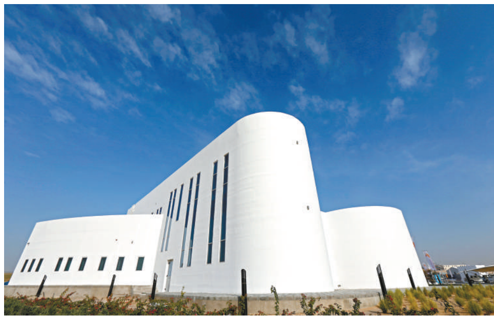
图为不久前竣工的阿联酋迪拜市政府办公楼,这是目前世界上最大的3D打印建筑。影像中国
