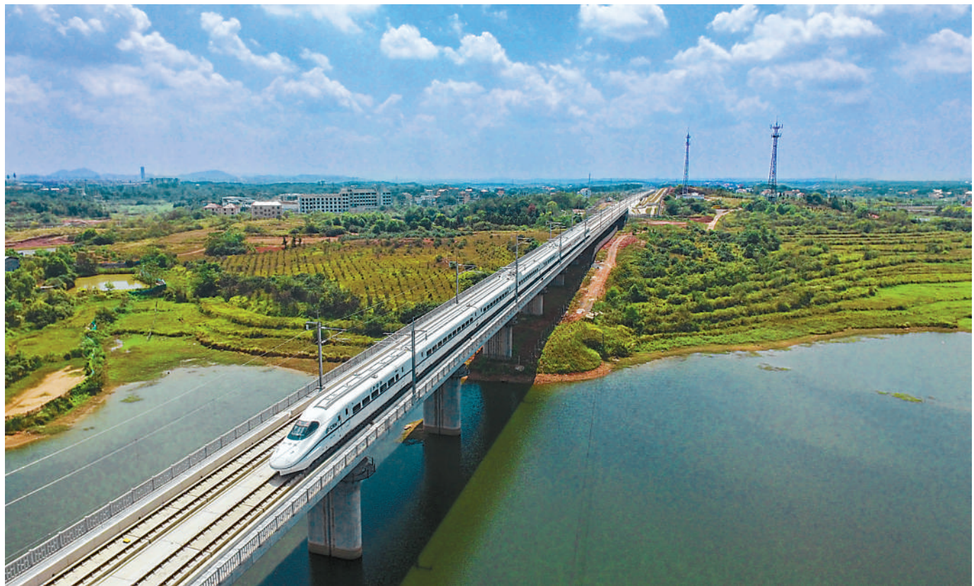
9月6日,(南)昌赣(州)高铁吉安西至赣州西及相关联络线正式进入联调联试阶段,综合检测列车同步上线,距开通运营指日可待。图为当日,综合检测列车行驶在昌赣客专6标段邹家特大桥上。 曾祥珍摄(影像中国)
