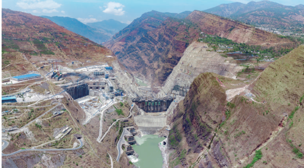
图为建设中的白鹤滩水电站。
