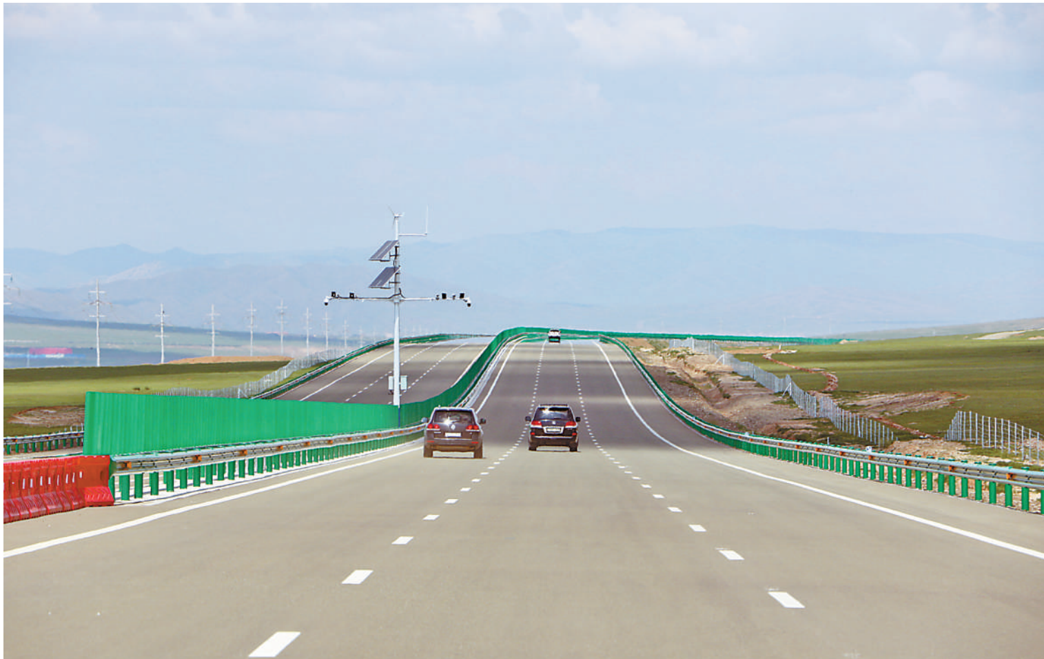
竣工移交的蒙古国首条高速公路。
