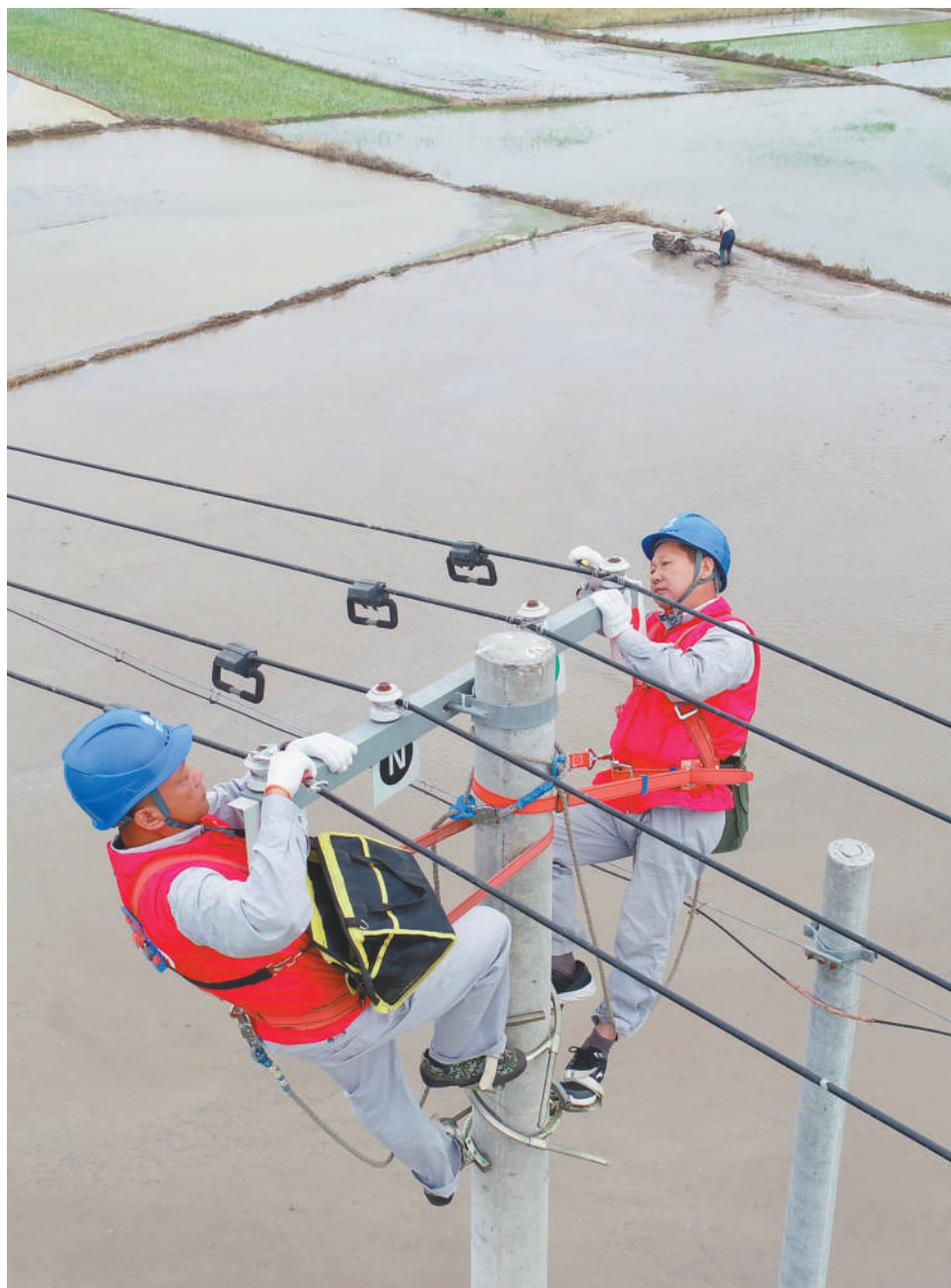
眼下正值安徽省滁州市农村夏播夏插时节，随着农业机械化作业的增多，用电安全成了滁州市供电公司工作重点。图为公司“红马甲”党员服务队队员在定远县仓镇小刘村架设新的农用供电线路，保障田间灌溉。 宋卫星摄(人民视觉)
