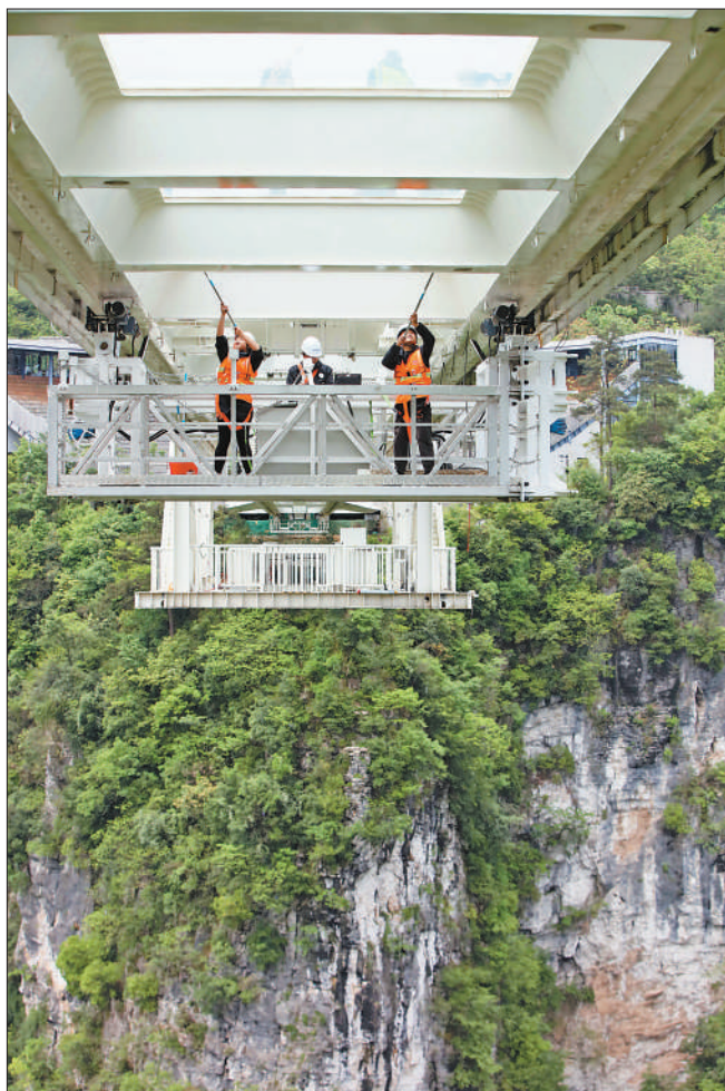
湖南张家界大峡谷玻璃桥全长430米,桥身距谷底垂直落差300米。近日,高空清洁工搭乘桥梁检修车对桥面玻璃进行保洁。 吴勇兵摄(影像中国)
