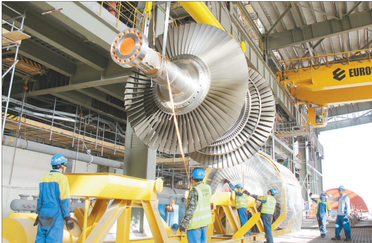
迪拜哈斯彦清洁煤电站是中东地区首座清洁燃煤电站,也是“一带一路”框架下中东地区首个由中资企业参与投资、建设和运营的电站项目。图为工作人员正在安装汽轮机低压缸转子。
