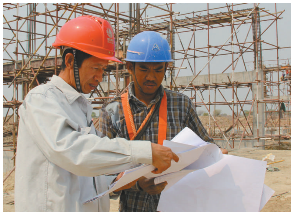
题图:中葡合作建设的葡萄牙拜罗风电站,每年发电量可达6.5万千瓦时。 本报记者 冯雪瑶摄 左图:2018年4月,中国和缅甸工作人员在缅甸实皆省的瑞保变电站紧张施工。 本报记者 孙广勇摄
