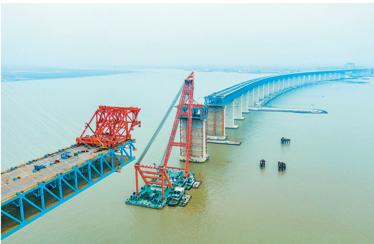
1月29日,连接江苏省张家港市和南通市的沪通长江大桥27号辅助墩第三段节间钢梁吊装对接成功,标志着主航道桥墩顶钢梁架体施工全部完成。图为吊装施工现场。 影像中国
