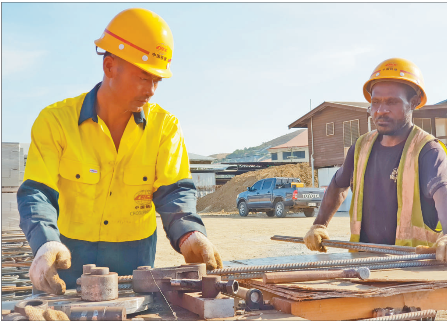
在中铁建设集团(巴新)有限公司的工地上,中国和巴新工人正在一同作业。
