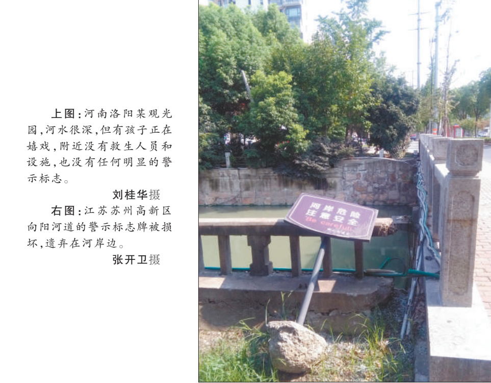
右图:江苏苏州高新区向阳河道的警示标志牌被损坏,遗弃在河岸边。
