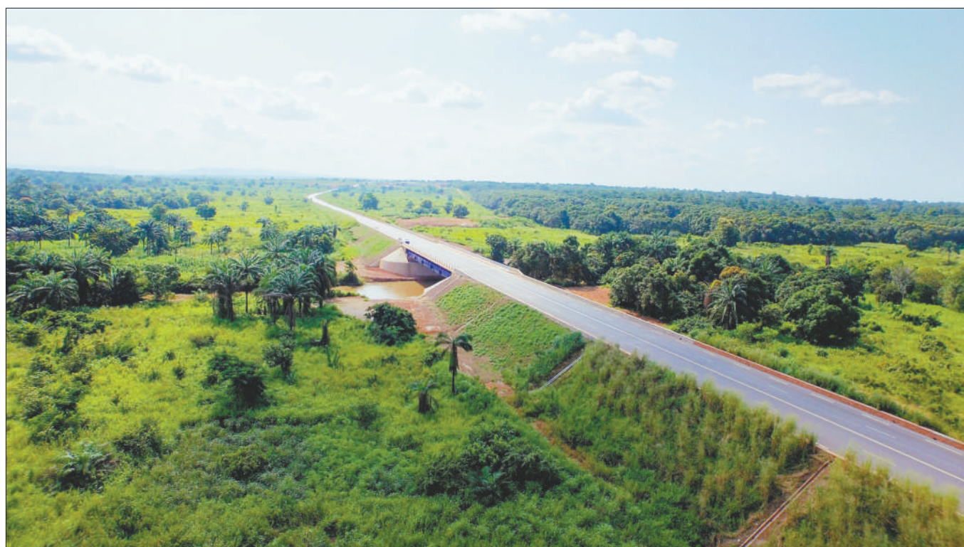
中国建筑承建的刚果(布)国家一号公路。
