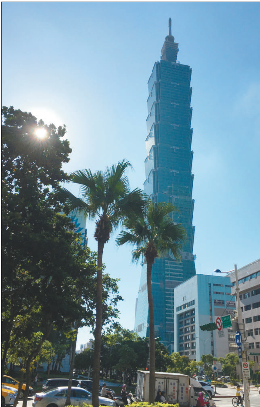
台湾“8·15”大停电，台北东区的“豪宅”也未能幸免，台北地标101大楼部分受到影响。本报记者 王尧摄
