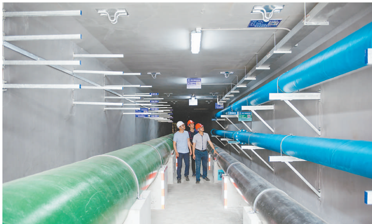
施工人员正在地下综合管廊检查设施维护情况。
