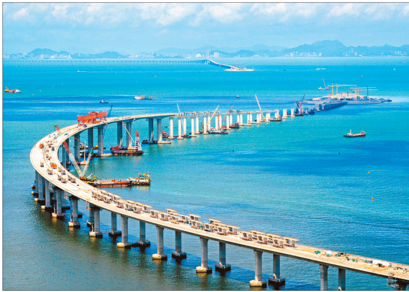
香港回归20年来,随着内地与香港人员交流愈加频繁,越来越多连接两地的工程落成;从每年都在增加的直通车班次到粤港基建工程,从往返两地的巴士到海上航线……这些粤港工程,极大地加强了两地之间的联系,为两地人员往来提供便利。图为建设中的港珠澳大桥。 新华社发
