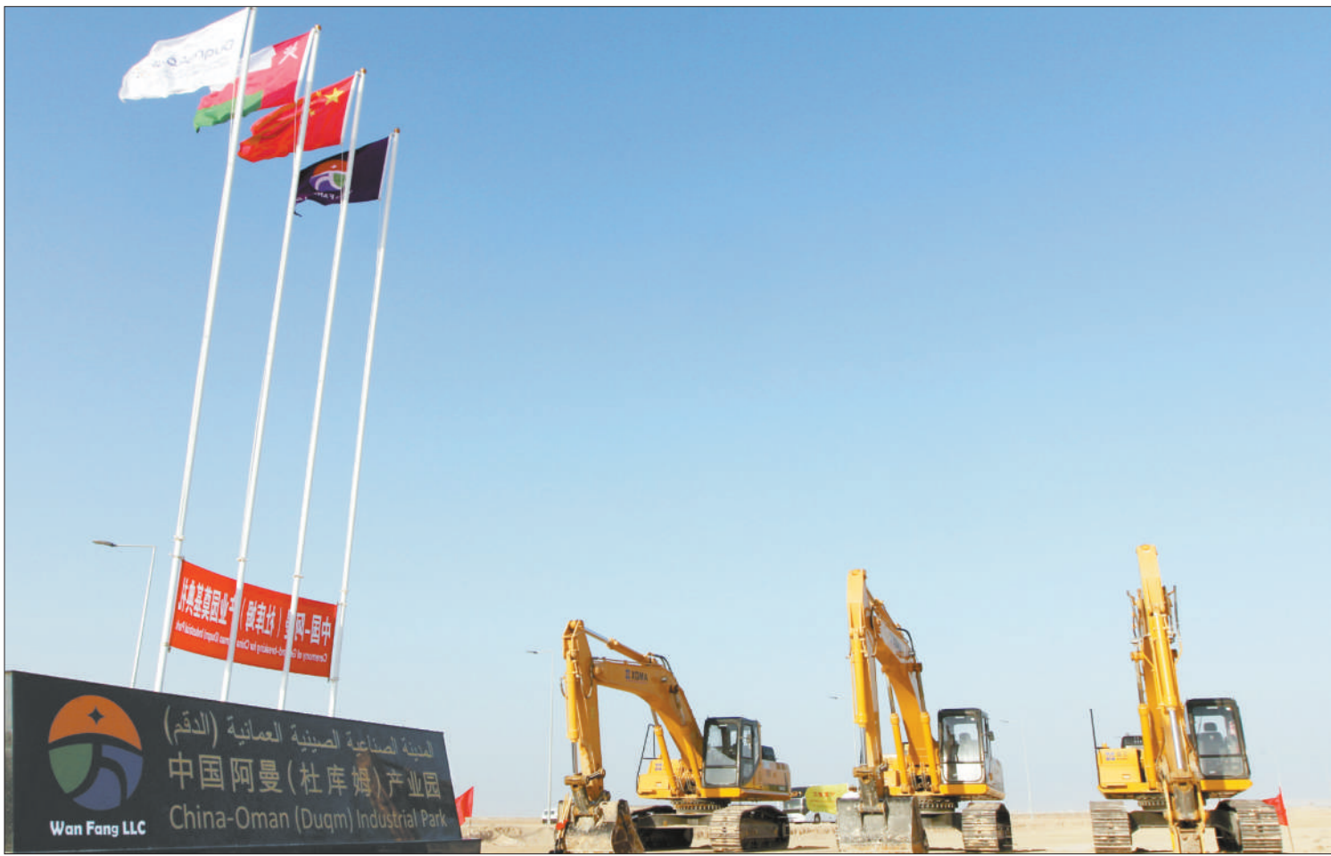
4月19日，中国—阿曼(杜库姆)产业园奠基礼在阿曼杜库姆经济特区举行。未来，一个现代化产业园将从这里拔地而起。图为中国—阿曼(杜库姆)产业园建设工地。
