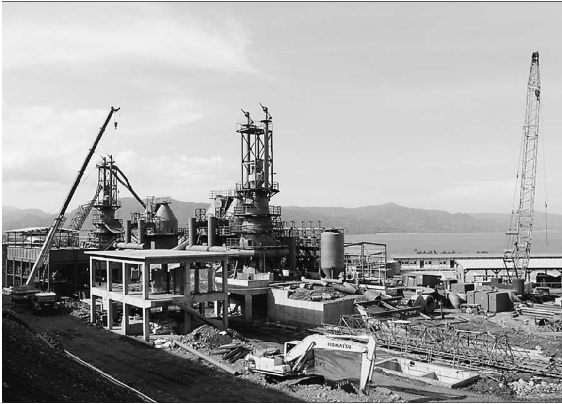
恒顺众昇苏拉威西镍铁工业园是中印尼两国产能合作的重要项目。图为园区施工现场。恒顺众昇供图
