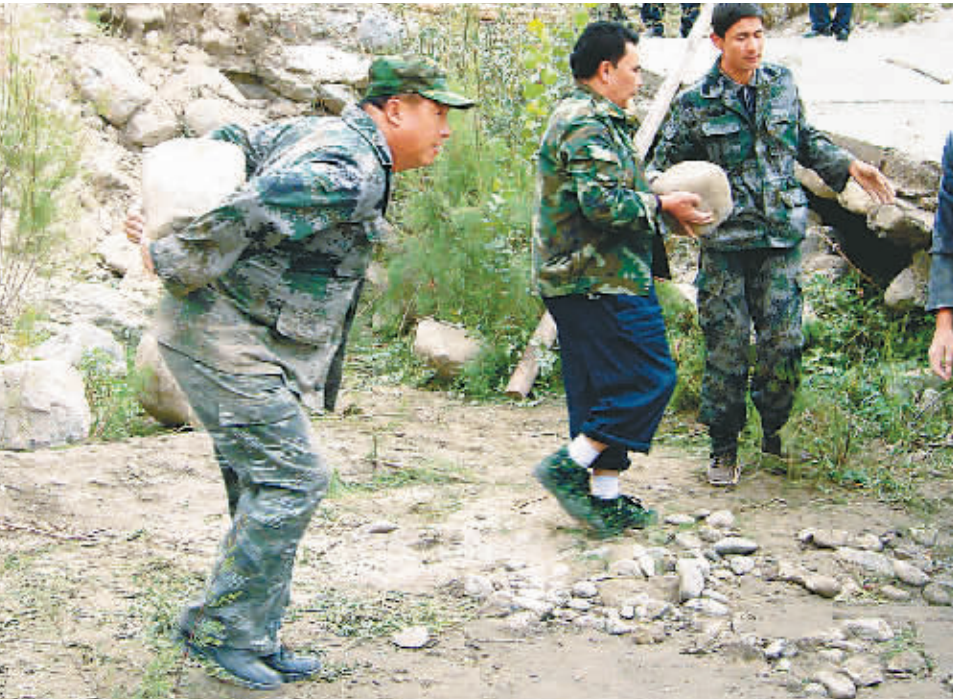
今年 8 月,师延林(左一)带领村民一起修筑防洪堤。
