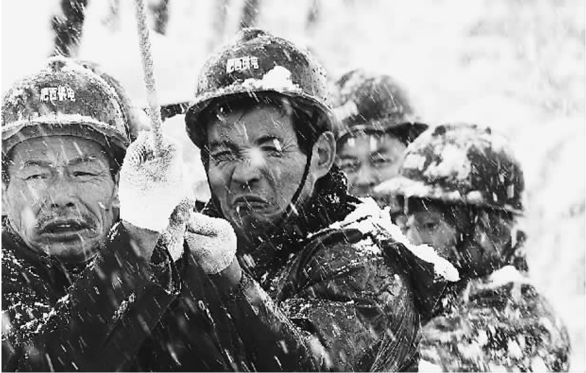
11月16日，安徽供电部门工作人员冒雪抢修线路。
