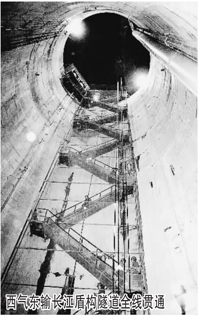
西气东输长江盾构隧道全线贯通 11 月 16 日,西气东输长江盾构隧道工程实现全线贯通。在隧道内,将铺设一根直径 1219 毫米、压力 10 千帕的天然气管道。长江盾构隧道 2008 年 6 月 1 日开工,是西气东输二线东段第一个开工的重点控制性工程,在江西省九江市和湖北省武汉市之间穿越长江,隧道水平长度为 2590 米。 魏东升 曹诚平摄影报道
