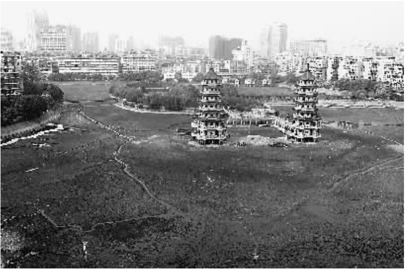
武汉市对中心城区的24个劣Ⅴ类湖泊实施清淤改造工程。
