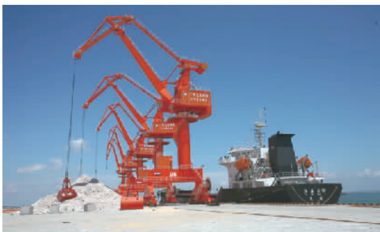
广西北部湾银行支持北海市铁山港区港口建设
