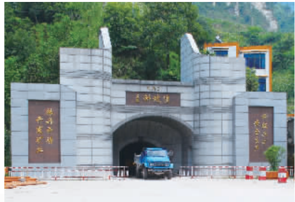
开磷集团矿业总公司马路坪矿860主斜坡道
