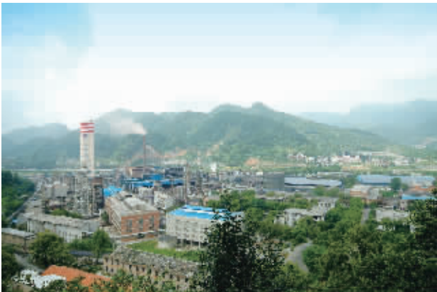
开磷集团剑化公司生产区一角
