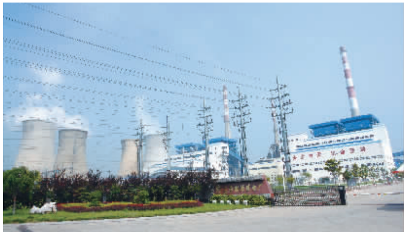
高效环保坑口发电厂
