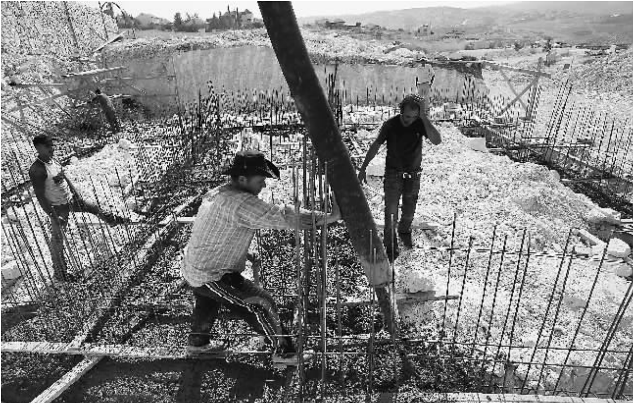
9月7日在约旦河西岸犹太人定居点Tekoa,工人正在搭建房屋。
