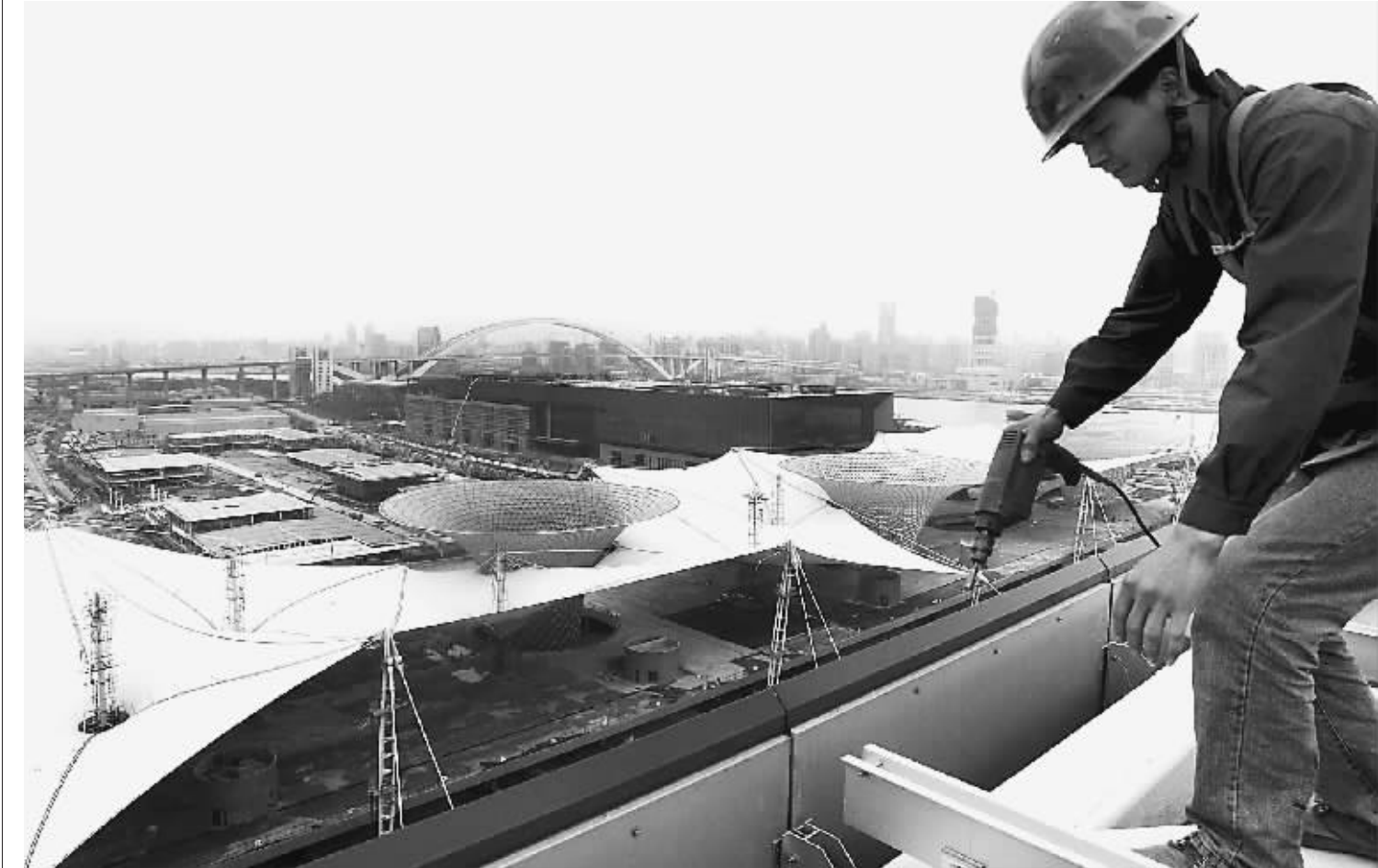
八月三十日，建设者将世博轴阳光谷最后一块膜布顺利安装到位，标志着世博园区内最大的永久性单体工程——世博轴阳光谷索膜结构工程全面完成。张海波摄（人民图片）
