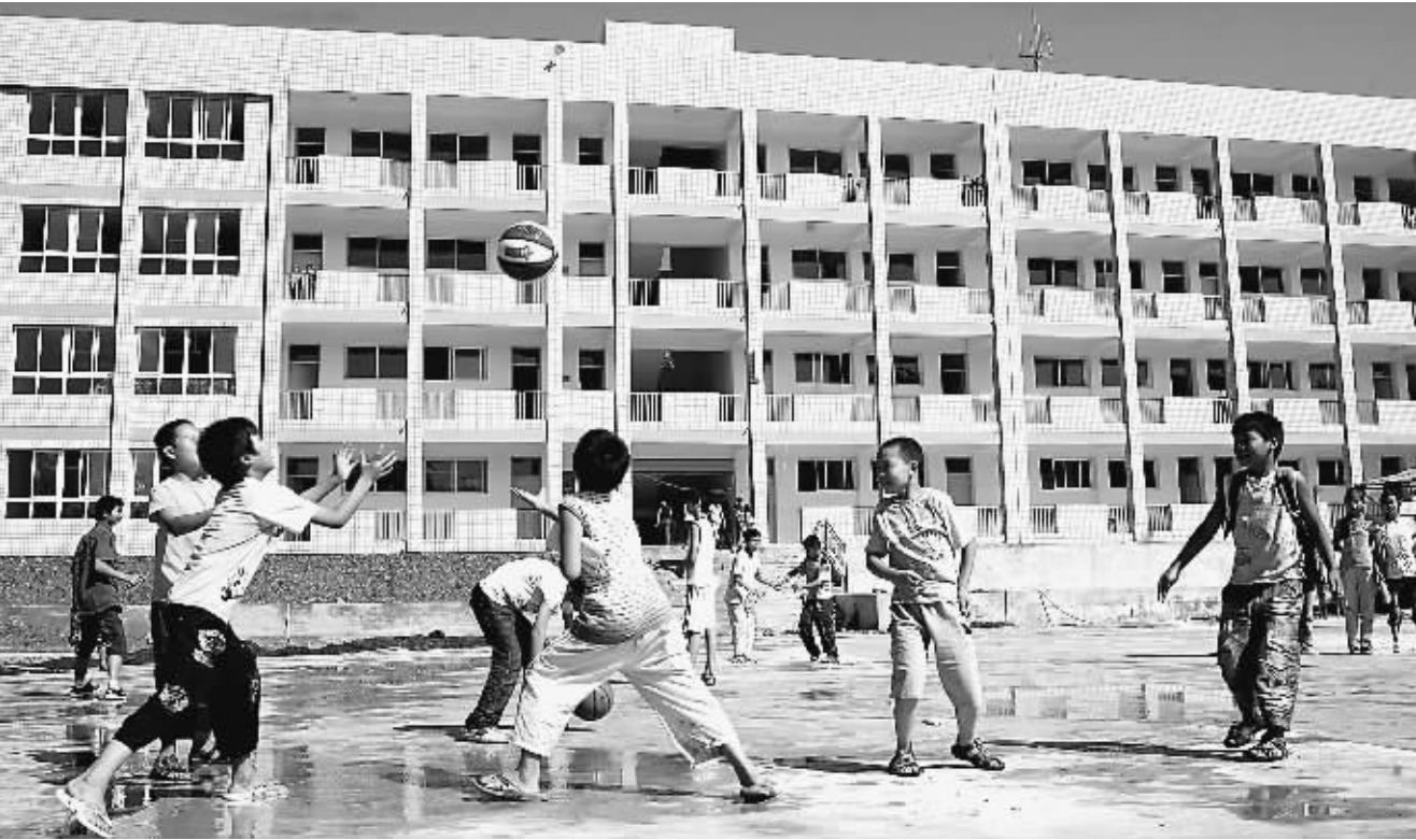
四川省华蓥市明月小学在汶川特大地震中教学大楼和教学设备遭到严重损坏,该校730多名学生分别疏散到就近的学校复课。该校筹资200多万元进行灾后重建,在原址上新建起2300平方米的教学大楼,使在外校借读的学生今秋开学前顺利返回入学。图为8月30日明月小学的学生在新落成的教学大楼前玩篮球。邱海鹰摄(新华社发)
