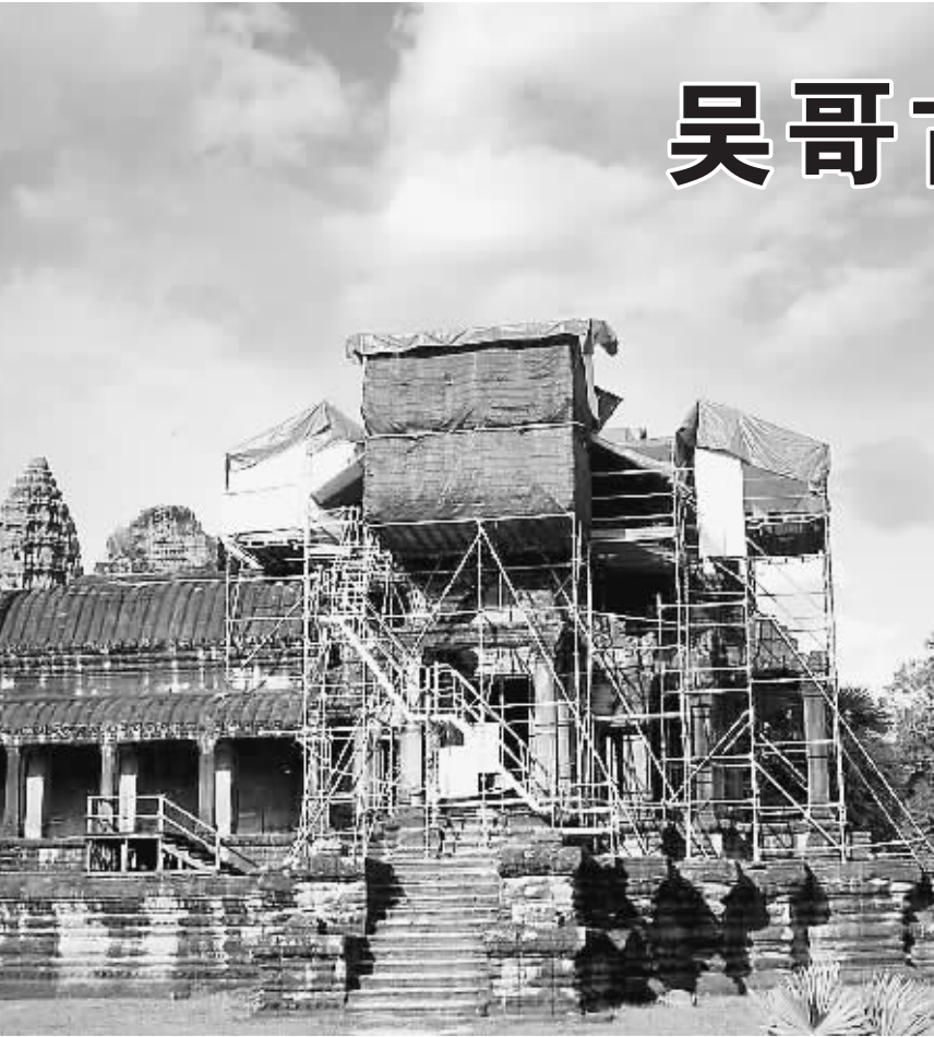
吴哥窟一处正在维修的建筑。
