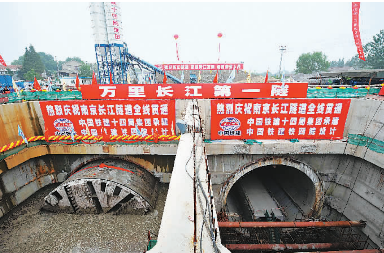
8月22日上午，南京长江隧道工程全线贯通，标志着中国长江流域工程技术难度最大、地质条件最复杂、挑战风险最多的越江隧道取得了重大突破，也标志着我国超大直径盾构隧道的科研与施工技术水平已世界领先。画面左侧是当日贯通的隧道，右侧是5月20日贯通的隧道洞口。 本报记者 陆娅楠文 新华社记者 陈琪摄
