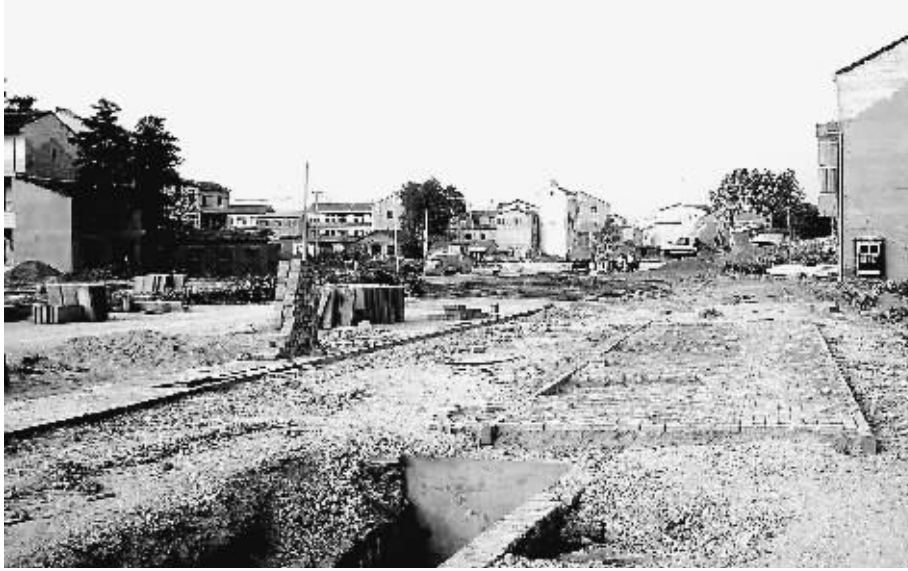
8 月 5 日，中北路延长线施工现场。田豆豆 廖婧 摄影报道
